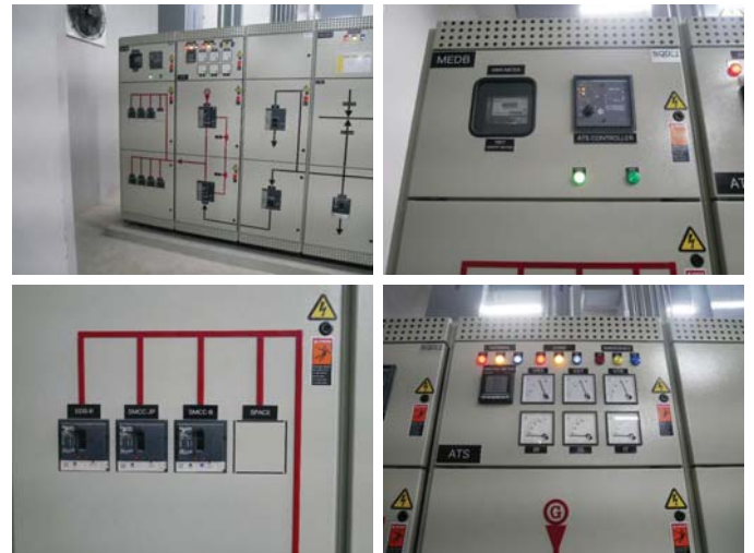
ภาพระบบไฟฟ้าสำรองจ่ายพลังงานไฟฟ้าให้ระบบสำคัญของอาคาร
