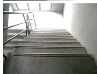
ภาพบันไดหนีไฟและเส้นทางหนีไฟ มีระบบแสงสว่าง ไม่มีสิ่งกีดขวาง ผนังหรือประตูทำด้วยวัสดุทนไฟ สามารถใช้หนีภัยในกรณีฉุกเฉินได้
