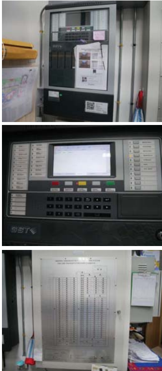
ภาพระบบสัญญาณแจ้งเหตุเพลิงไหม้ ตู้ FCP และ Graphic Annunciator มีการตรวจสอบเบื้องต้นจากทางฝ่ายอาคาร
