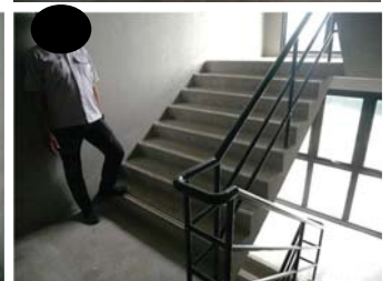
ภาพบันไดหนีไฟและเส้นทางหนีไฟ มีระบบแสงสว่าง ไม่มีสิ่งกีดขวาง ผนังหรือประตูทำด้วยวัสดุทนไฟ สามารถใช้หนีภัยในกรณีฉุกเฉินได้
