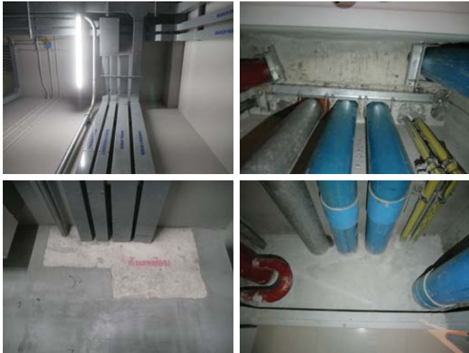
ภาพการปิดช่องเปิดระหว่างชั้น (ขาร์ปงานระบบ) ป้องกันการแพร่กระจายควันไฟ
